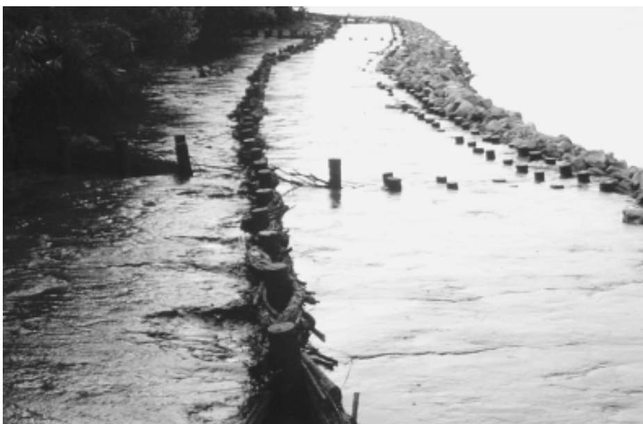
Fig. 2. Het resultaat van terrasbouw door middel van perkoenpalen en vlechtwerk van wilgenteenbussels als alternatieve schorrandverdediging ter hoogte van de Zogge te Moerzeke-Kastel langs de linkeroever van de Zeeschelde.
