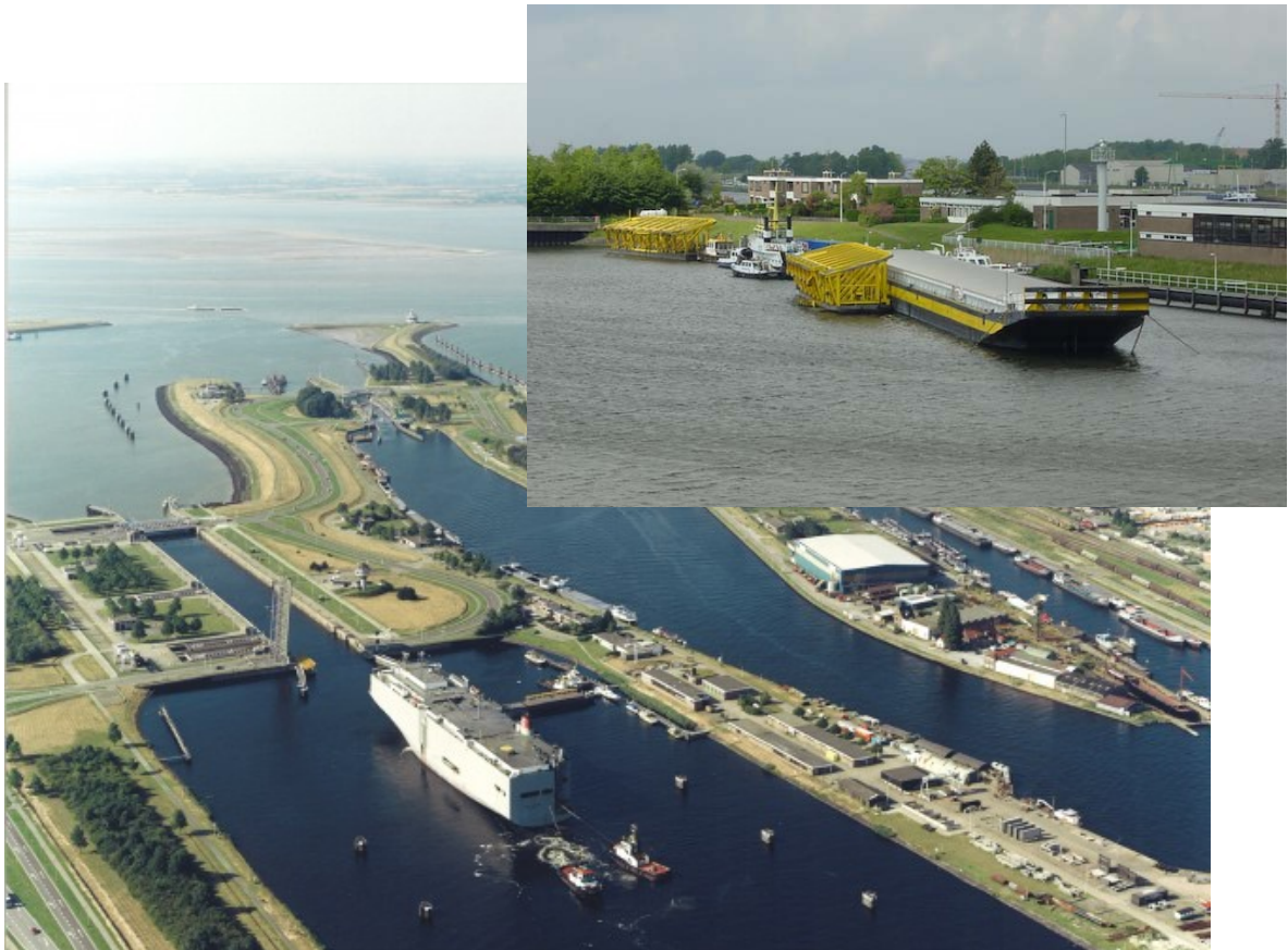
Figuur 2-2: Bufferbakken Westsluis (© KGT2008, Cees van de Vrie)
