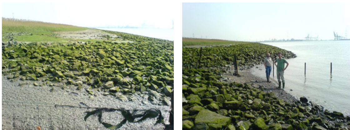
Figuur 5.2: Links: Schorrandverdediging Galgeschoor ter hoogte van de zwaaizone (foto's Mindert de Vries). Rechts: Hoogteverschil schor en slik. Let op de hoogte van de verdediging, vergelijk met lengte personen.
