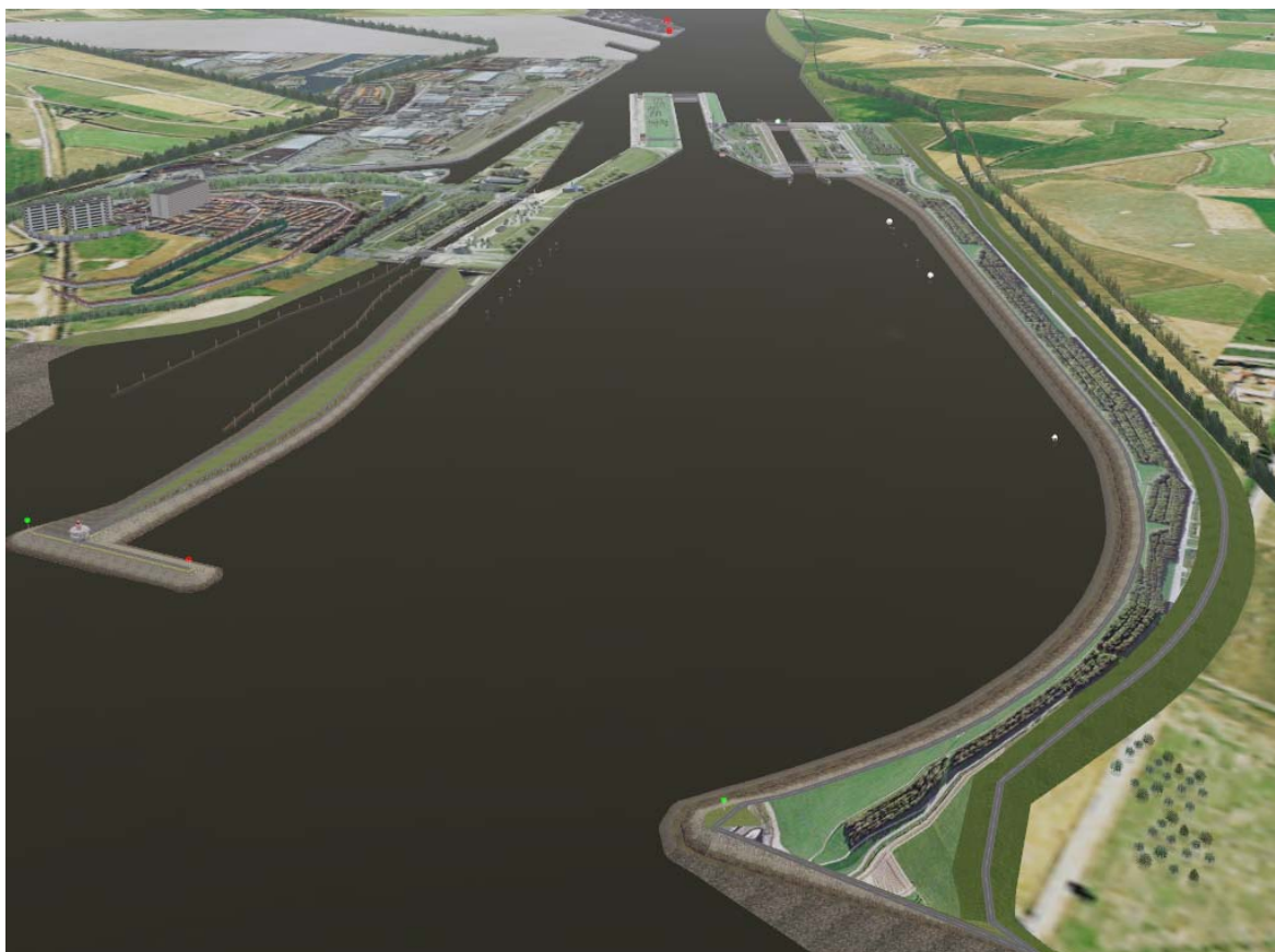
Figuur 7 – Buitenbeeldzicht van de zuidelijke inplanting van op de rivier
