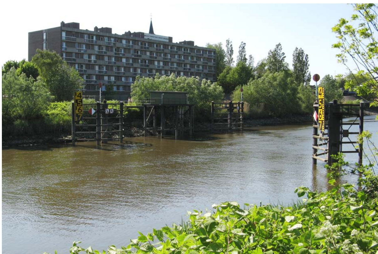
Figuur 41 - Boven-Zeeschelde te Melle: foto's van de meetinstallatie van de tijmeetpost en van de akoestische debietsmeter
