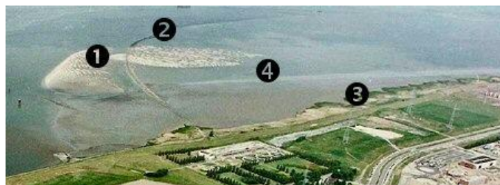
Figuur 2-24: Deze luchtfoto toont de ballastplaat (1), de stroomleidam (2), de smalle strook schor (3) en de uitgestrekte slikplaat en vloedschaar (4) (Scheldeschorren, 2012).
